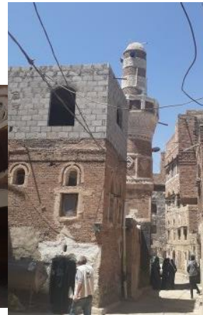
(٦ ، ٧) توضح البناء الاسمنتي للتوسعة في مسجد الصياد، وبناء بالبلك فوق مباني تابعه للمسجد
